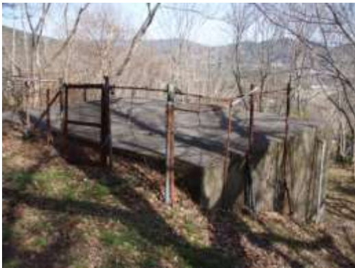
装置設置前（沈殿槽）
